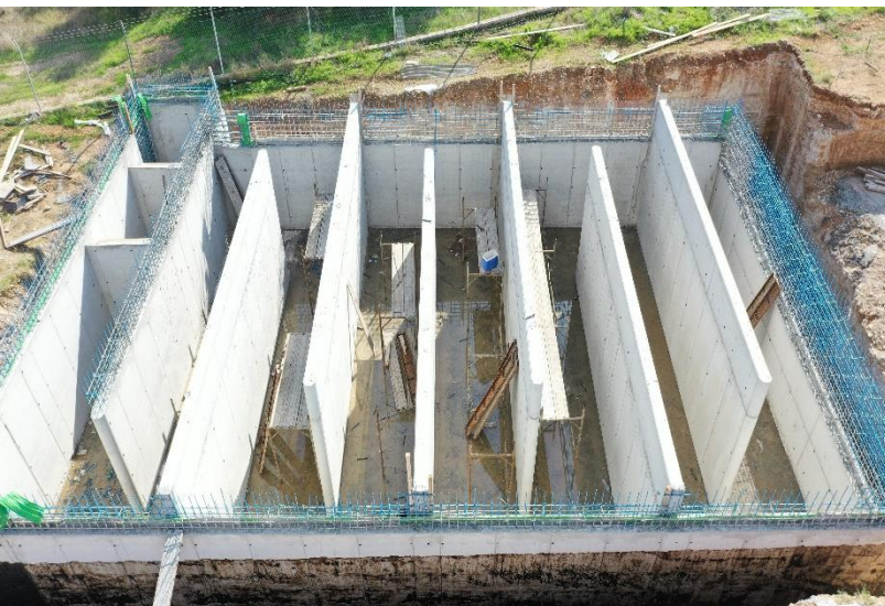
Εικόνα 5 – Μαιανδρική διάταξη της δεξαμενής χλωρίωσης
