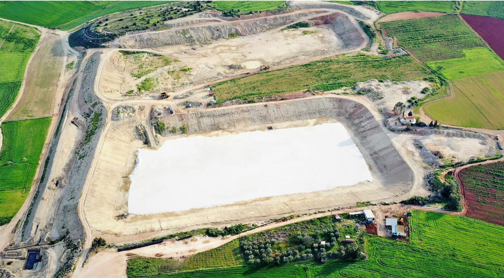
Εικόνα 7 – Δεξαμενές μακροπρόθεσμης αποθήκευσης ανακτημένου νερού
