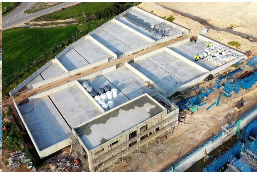
Εικόνα 6 – Κτίριο αποθήκευσης ιλύος
